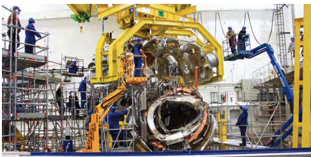
Die Montage von Wendelstein 7-X im IPP-Teilinstitut Greifswald ist in vollem Gange
