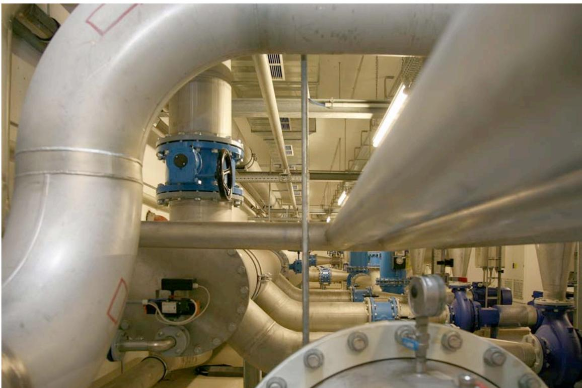
*Blick in die kühle Unterwelt von Wendelstein 7-X: Mehr als ein Kilometer Rohrleitungen unterschiedlichster Weite wurde für das Kühlsystem verbaut (Foto: IPP, Anja Richter-Ullmann)*
