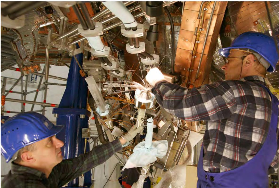
*Schwierige Verbindung: In aufwändiger Handarbeit montieren Spezialisten aus Krakau die komplexen Anschlussstücke für die supraleitenden Magnetspulen von Wendelstein 7-X (Foto: IPP)*
