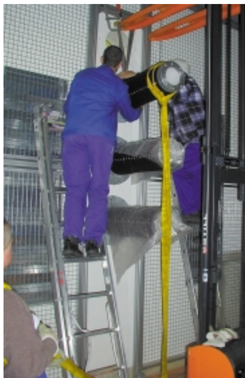
Montage der Hochspannungsdurchführung für die Gleichstromversorgung im IPP-Teilinstitut Greifswald.
